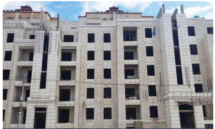
واجهة أمامية في مشروع الماصيون جاردنز 2 توضّح أعمال التشطيب.
