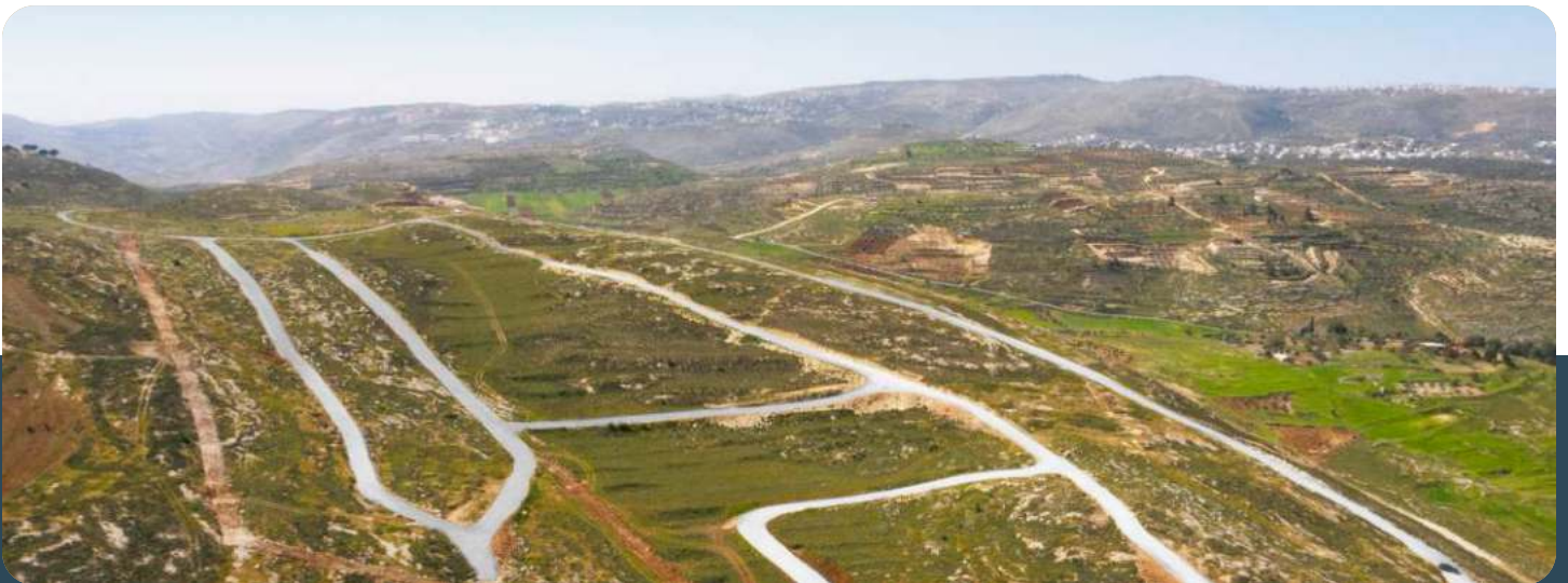
تنفيذ أعمال البنية التحتيّة في ترمسعيّا، وإنجاز تعبيد الطرق بالكامل.
